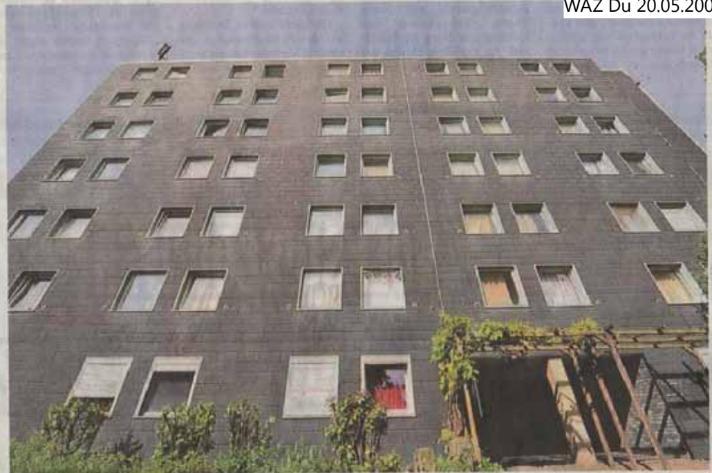
Die Schieferfassade samt Wärmedämmung soll im Wintersemester erneuert werden.
